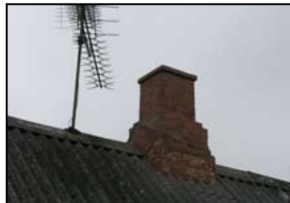
Skorsten på bygning 4.
