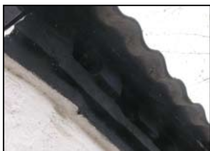
Gesims med udluftningshuller i bygning 3.
