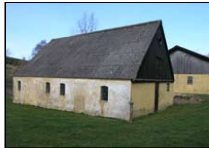
Bygning 3 - staldbygning til svinehold
