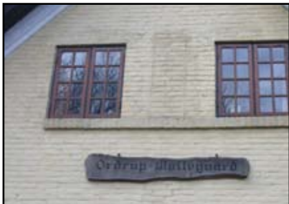
Nye småsprossede vinduer på 1. sal i stuehuset
