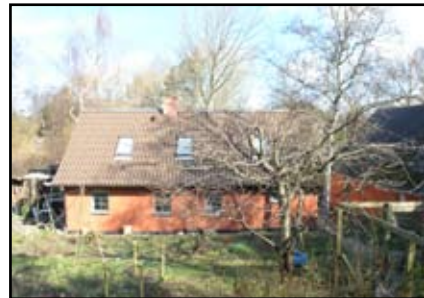
Stuehus set fra havesiden
