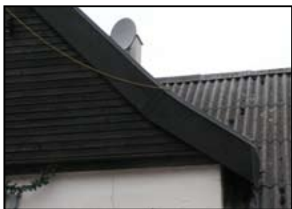
Bygning 1's vindskede og bræddebeklædning på gavltrekant.
