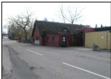
Bygning set fra Ordrupvej. Bygningen er bygget sammen med naboejendommen.
