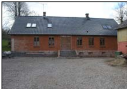
Bygning 1 'stuehus' set fra gårdsiden
