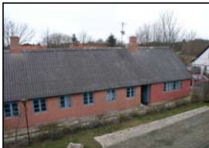
Bygning 4 'stuehus set fra gårdsiden
