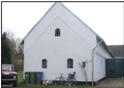
Staldbygning forhøjet med en trem-pel.
