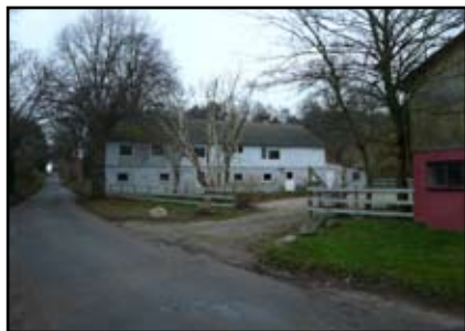
Nyere bygning til ferieformål
