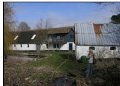
Den vestlige del af ejendommen. Til højre ses en del af det vinkelbyggede udhus.
