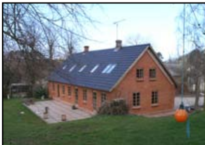
Bygning 1 'stuehus' set fra havesiden
