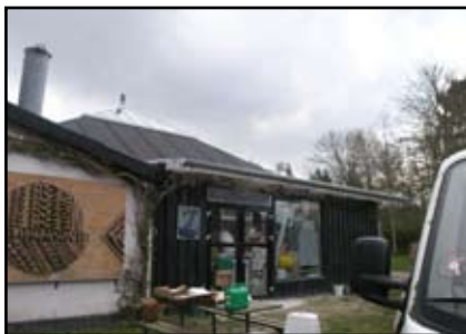
Tilbygning til bygning 3 og 4
