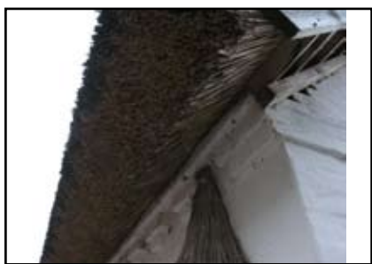
Muret gesims under stråtag
