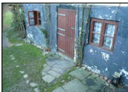
Kælderdoor under stuehus
