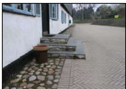
Pigstensbelægning langs bygning mod vej.
