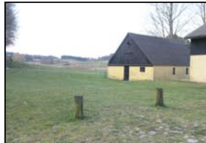
Stuehus set fra havesiden
