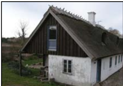
Forlængelse af bygning har resulteret i en overdækket terrasse
